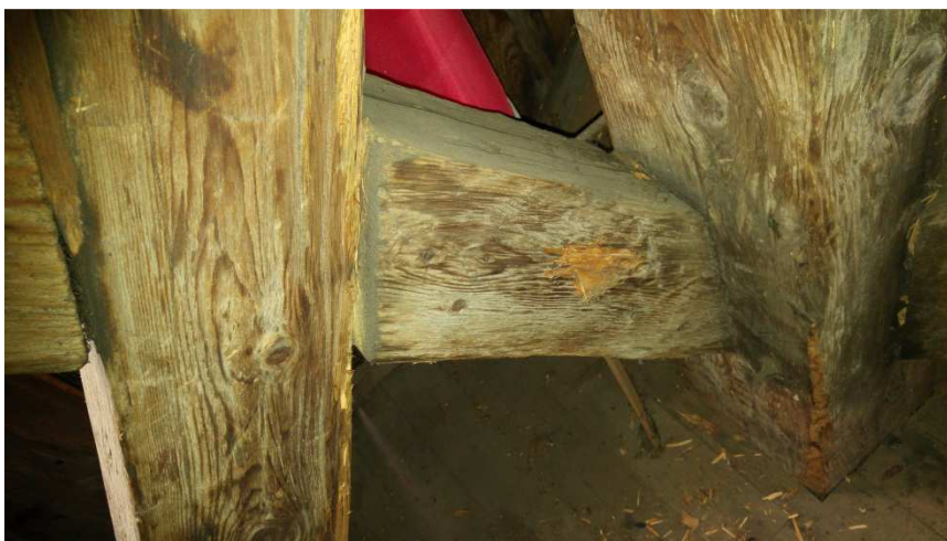
Foto.17 – stan elementów konstrukcji kondygnacji dzwoniczej
