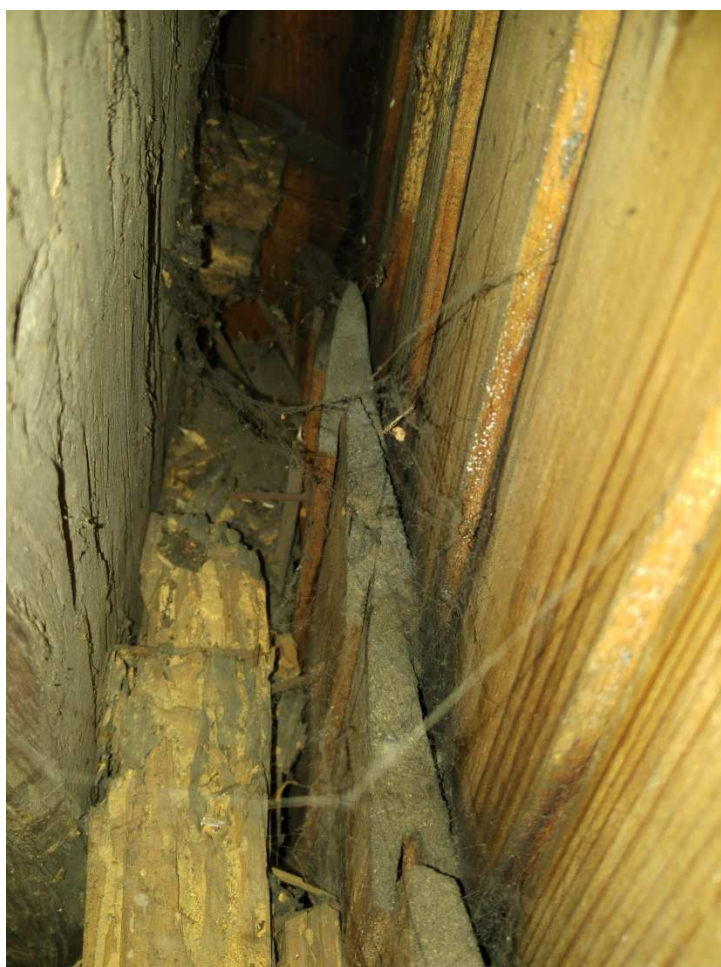
Foto.19 – uszkodzenie w strefie podparcia rygli ściennych
