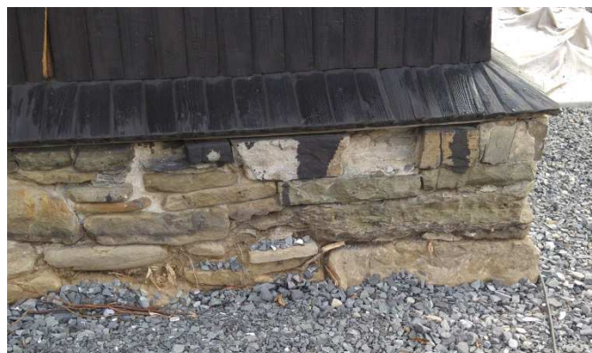
Foto.5 – widok ubytków zaprawy oraz korzenie
