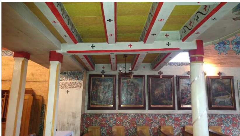
Foto.23 – konstrukcja stropu chóru
