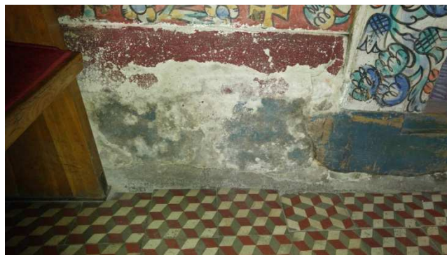
Foto.6 – zawilgocenie i korozja ściany
