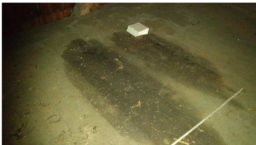
Foto.20 – wilgoć na podłodze stropu nad przedsionkiem chóru
