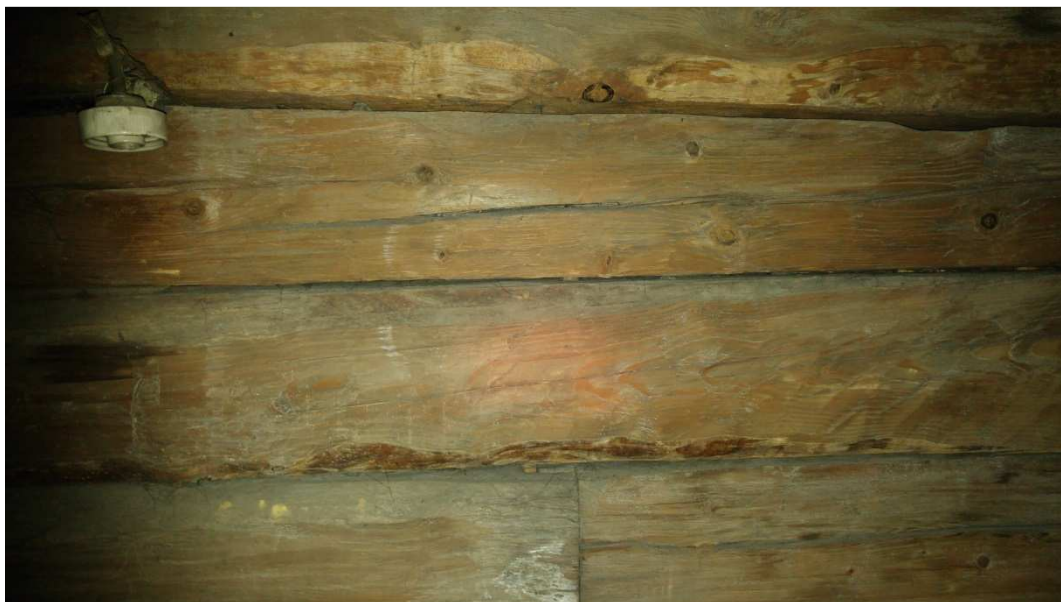
Foto.7 – widok ściany wieńcowej
