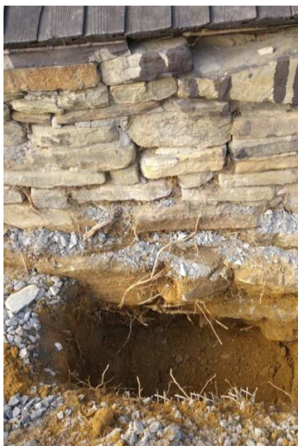
Foto.4 – odkrywka fundamentów
