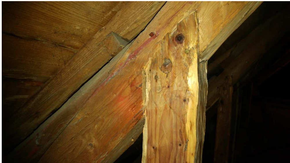
Foto.12 – uszkodzony węzeł słupka
