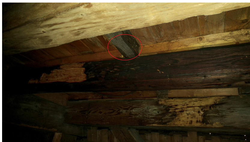
Foto.21 – prawdopodobnie zawilgocone belki
