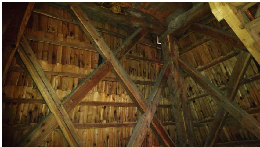
Foto.13 – konstrukcja szkieletowa wieży
