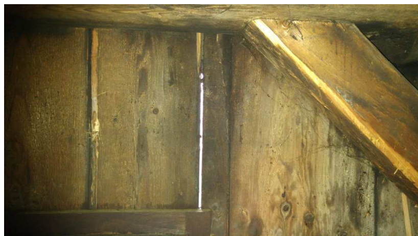
Foto.22 – szczeliny w obudowie z desek
